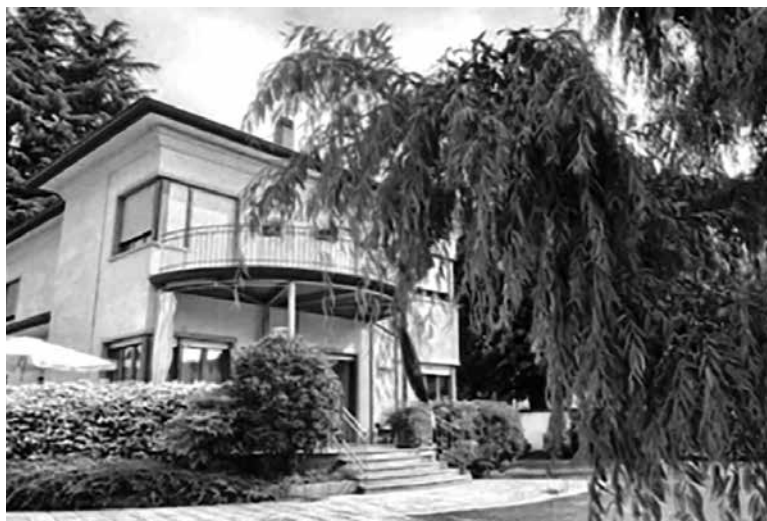
La struttura di via Carlo Dell'Acqua
